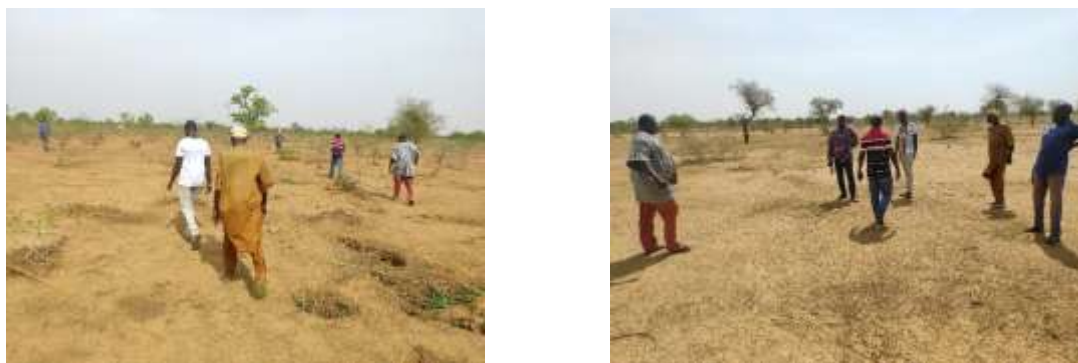
Figure 20 : Vue du site portion centrale solaire au raccordement de la ligne existante 132KV
