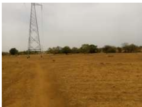
Existence d'une ligne électrique fonctionnelle
