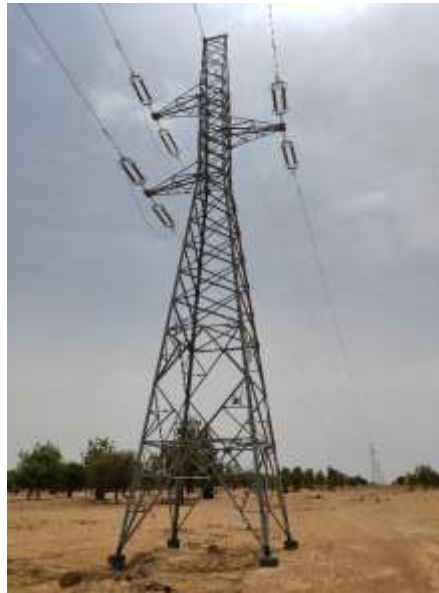
Figure 36 : Voie de la maintenance de la ligne existante 132 KV
