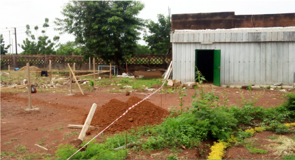
Le nouveau siège du centre de Dédougou en construction est attendu en avril 2023.
